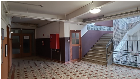
[22] La hamaka ŝtuparejo en la 2a etaĝo. Duonetaĝon malsupre oni videtas la enirejon al la salono La Ĉangalo . La granda pordo en la fono maldekstre gvidas al la dormĉambroj en C2 kaj al la salono La Svarmo . La ŝtuparo supren gvidas al la dormĉambroj en C3, D3 kaj E3.
